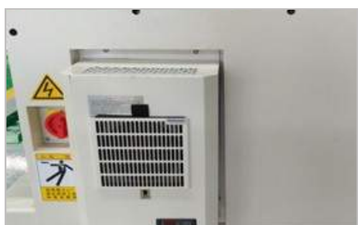
Hệ thống làm mát tủ điện
